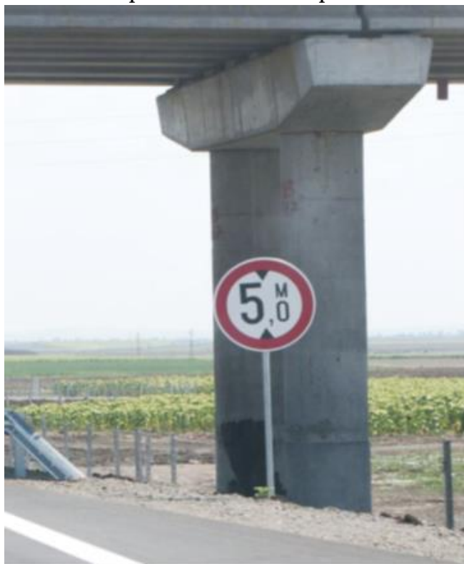
Фиг.13. Неправилно поставен пътен знак В16, отразяващ съществуващата височина до съоръжението, а не допустимата височина на ППС
