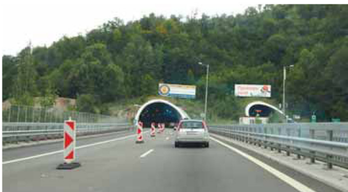
В новоремонтирания тунел „Витиня“ на АМ „Хемус“ вече има модерни системи на извествяване, звукова сигнализация и осветление
